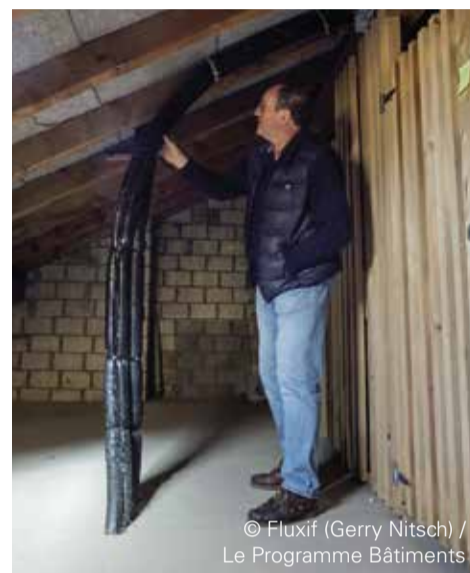
L'assainissement de l'isolation permet de réaliser des économies d'énergie importantes.
